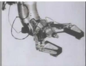
Figure 1.49: H. A. Ernst (MIT 1961): Computer control of mechanical arms using touch sensor.
